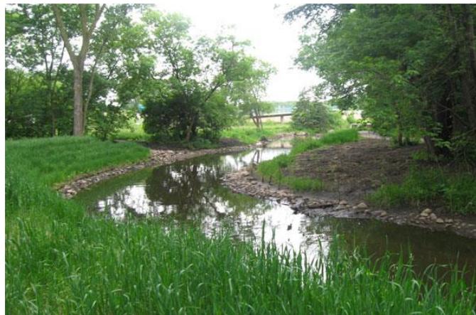
32. ábra Vízpart stabilizáció (Forrás: http://www.goldenvalleymn.gov/surfacewater/stream-bank-stabilization.php )
