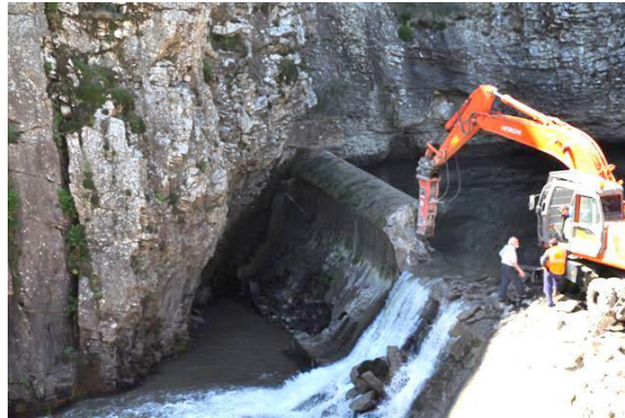
31. ábra Gát lebontása (Forrás: http://www.rivernet.org/general/dams/decommissioning_fr_hors_poutes/brivescharensac_f.htm )
