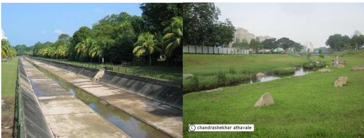
30. ábra Vízfolyásmeder visszaállítás természetes formába (Forrás:
