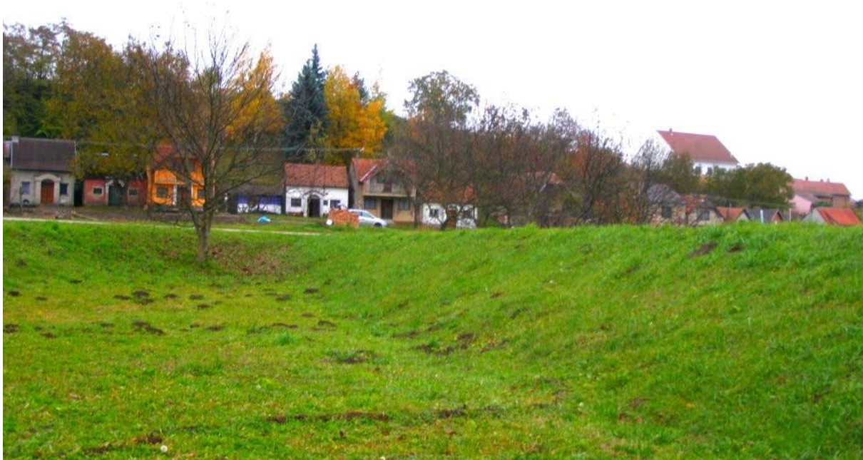
ábra 25. Gyepes beszivárogtató teknő (forrás: https://vizmegtartomegoldasok.bm.hu )
